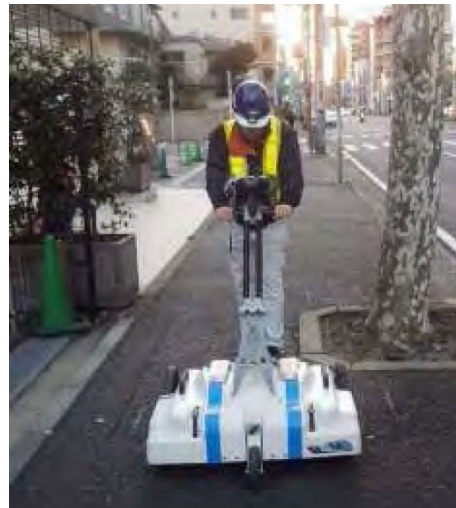
地中レーダを活用した調査(機械)
