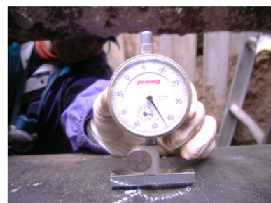
管外面の腐食深さを計測
